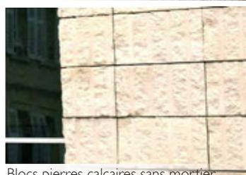
Blocs pierres calcaires sans mortier
