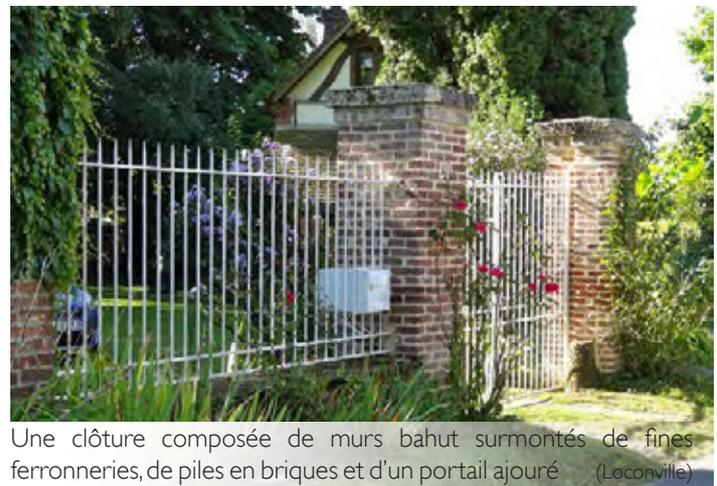
Une clôture composée de murs bahut surmontés de fines ferronneries, de piles en briques et d'un portail ajouré (Loconville)
